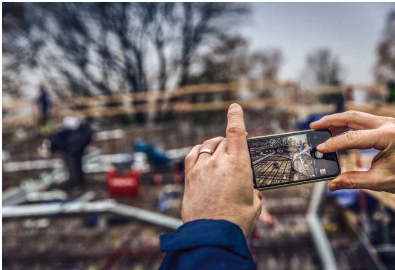
Kapellehusen är en populär produkt som Riksbyggen vill jobba vidare med. »Med det här projektet vill vi hitta nya arbetsätt som kan spridas och bidra till en omställning av hela byggsektorn«, säger Karolina Brick, miljöchef på Riksbyggen.
